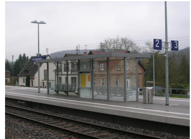
Abb.: Wartehaus auf dem Bahnsteig
