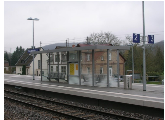
Abb.: Wartehaus auf dem Bahnsteig
