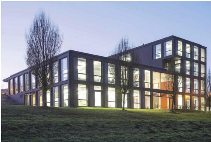
„Blue Office“ ist ein zukunftsweisendes Bürogebäude am östlichen Rand des Technologie-Quartiers in Querenburg. Bild: Jörg Hempel, Aachen
